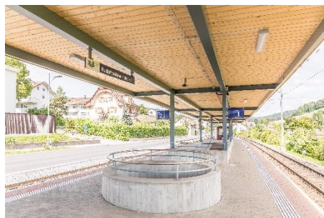
EV_S17_Hofacker_1.jpg Saniertes Haltestellendach Rudolfstetten Hofacker
