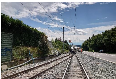
EV_S17_Hammergut_1.jpg Montage eines neuen Fahrleitungsmasten und bereits installierte, neue Weiche bei Zufikon Hammergut
