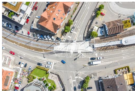
EV_S17_BueBerikon_1.jpg Luftaufnahme des sanierten Bahnübergangs
