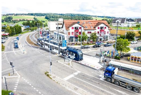
EV_S17_BueBerikon_2.jpg Luftaufnahme des sanierten Bahnübergangs
