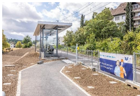
Die Hauptarbeiten an der Haltestelle Bremgarten Isenlauf sind abgeschlossen.
