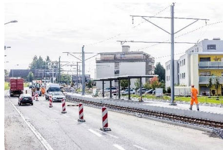
Neues Perron mit Wartebereich (05. Oktober 2023)
