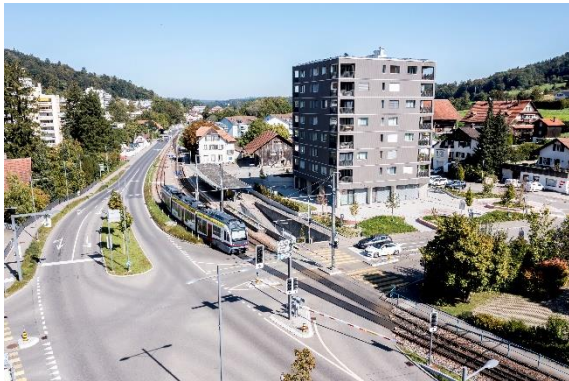
Der Bahnübergang «Friedlisberg» in Rudolfstetten wird im Oktober 2023 in der zweiten und letzten Etappe fertig saniert.
