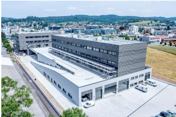
Luftaufnahme des Gewerbeparks «CreaPark14» mit den sichtbaren Zufahrtstoren des Busdepots.
