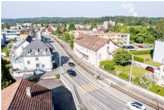
Luftaufnahme der Aarauerstrasse mit beiden Übergängen, die zusätzlich mit Barrieren gesichert werden.
