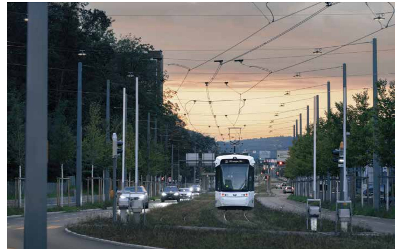
Die Anlagengattung «Bahnstromanlagen» beinhaltet die Fahrleitungsanlagen, Schaltposten und übrige Bahnstromanlagen, welche für die elektrische Energieversorgung der Züge benötigt werden.
